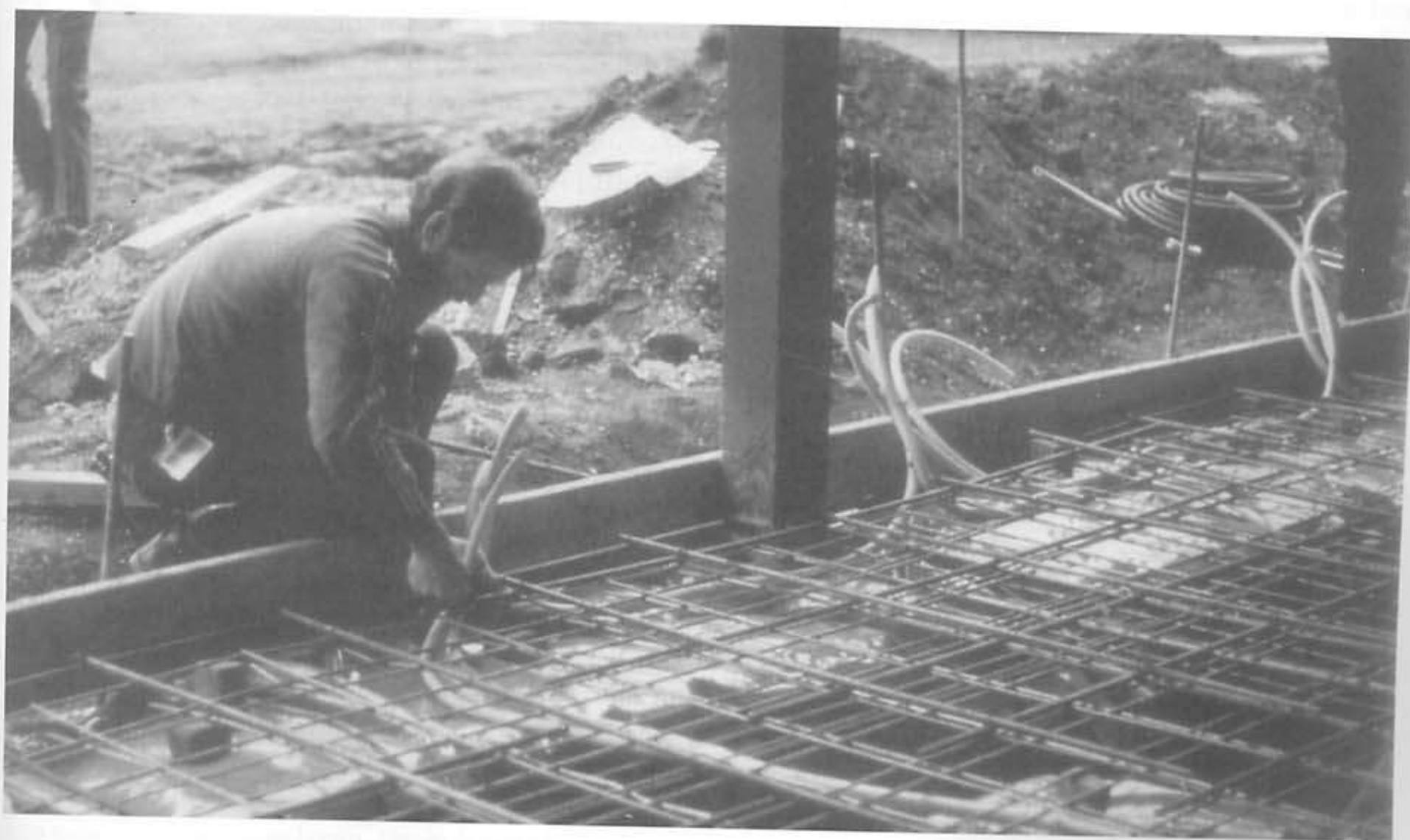
Fig. 9.2 Installing corrugated PVC conduit in a concrete pour
